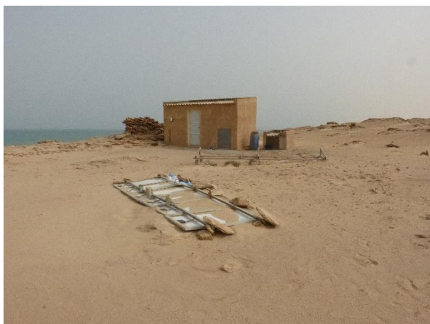
Réparation de l'installation des panneaux solaires endommagés par la tempête. Juin
