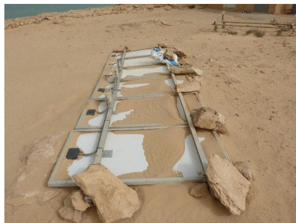
Réparation de l'installation des panneaux solaires endommagés par la tempête. Juin
